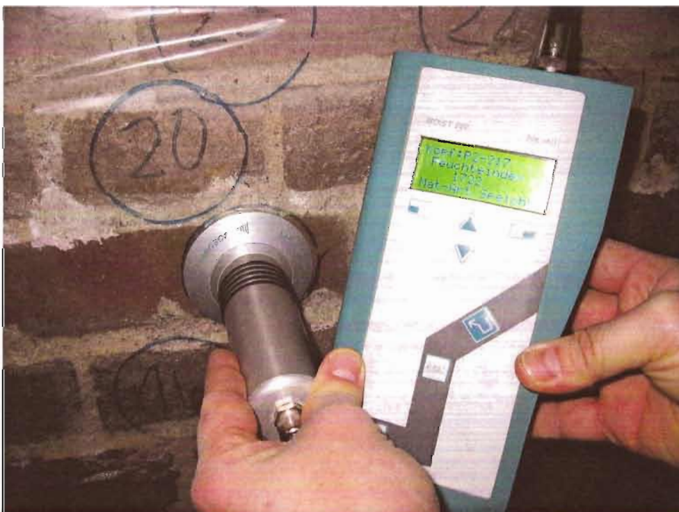
Bild 6: Feuchtemessung mit dem Mikrowellenmessgerät
