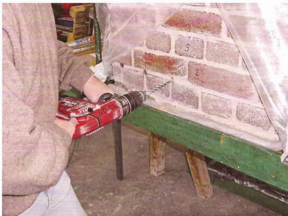
Bild 2: Bohren der Injektionskanäle
