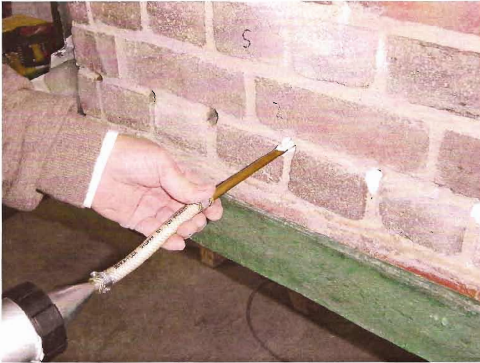
Bild 3: Injektion von DRYZONE
